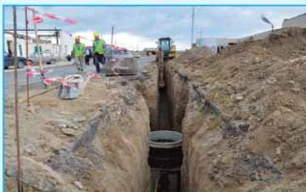
ilkin mərhələdə yeni salmış yaşayış massivinin içmeli su təchizatının yaxşılaşdırılması məqsədilə müxtəlif diametrlı polietilen borularla 3500 metr uzunluğunda su xətti çəkilir. Layihəyə uyğun olaraq ərazidə 22 ədəd siyirtmə, 12 ədəd yanğın hidrantı quraşdırılacaq. İşlər tam başa çatdıqdan sonra Məhəmmədi qəsəbosunun yeni yaşayış massivində 180 ailə mərkəzləşdirilmiş qaydada içmeli su alacaq. Qeyd edək
